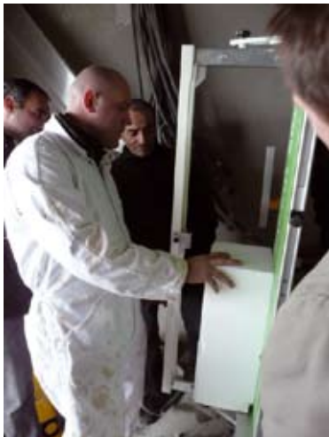
Mise en œuvre de l'isolation extérieure
